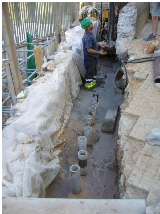
Foto n° 37 i 38: realització dels pilotis
