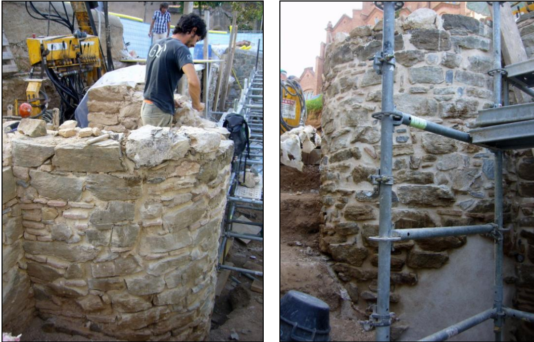
Foto nº 31 i 32: procés de reposició de junts i aspecte final
