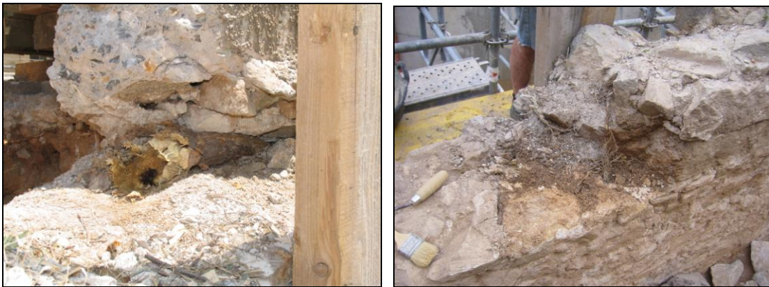
Foto nº 23 i 24: arrels i disgregació de morter
