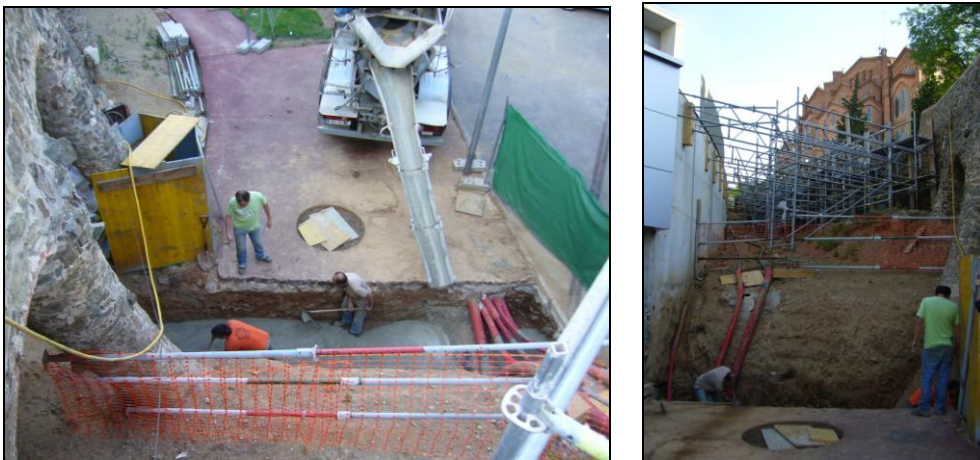
Foto nº 33 i 34: recalçament de formigó
