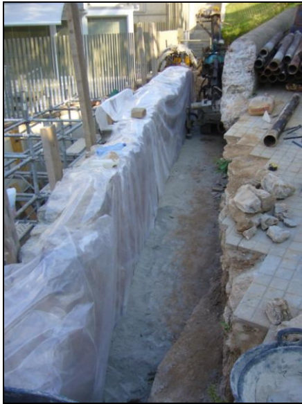
Foto n° 35 i 36 : protecció de l'estructura amb plàstic
