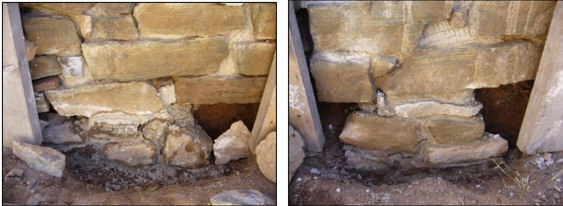
Foto nº 12 i 13: reintegració parts baixes del mur
