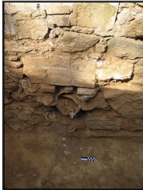
Desguàs de la claveguera
