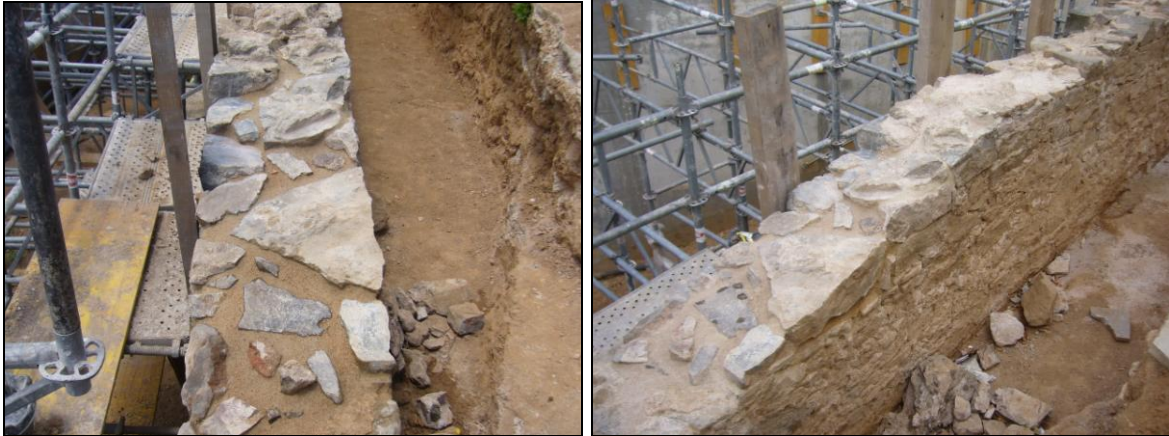
Foto nº 27 i 28: aspecte final dels coronaments
