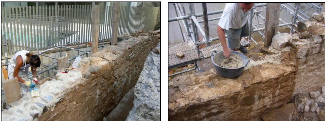
Foto nº 25 i 26: procés de reposició de junts a la part superior
