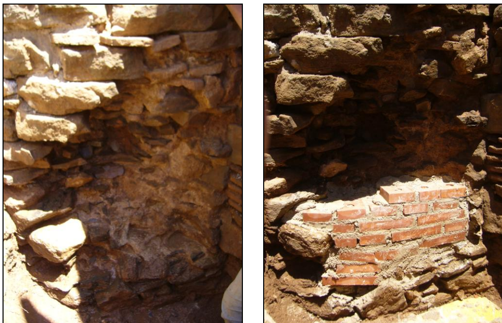
Foto nº 14 i 15: re ompliment de pèrdua de volum a la torre
