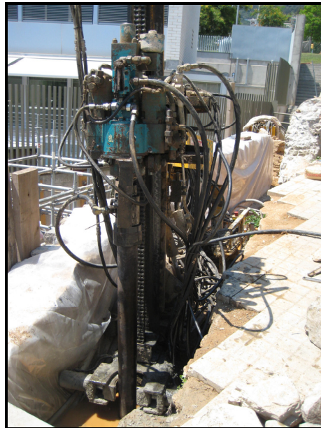
Imatge dels treballs de micropilotatge
