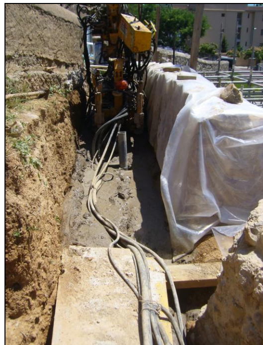
Foto n° 37 i 38: realització dels pilotis
